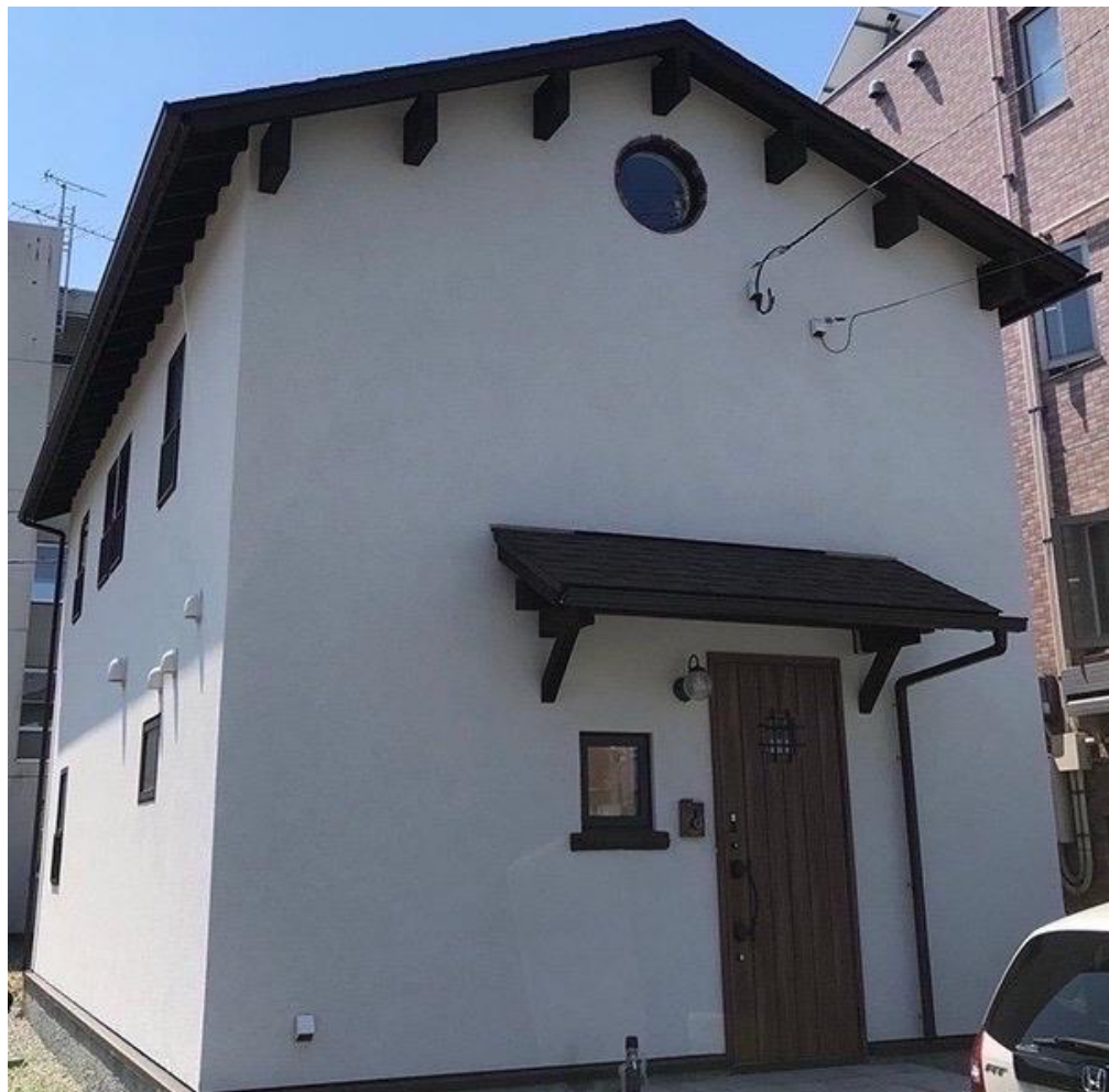
対象住宅 外観 撮影日：2022年9月8日
