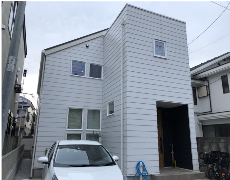
対象住宅 外観 撮影日：2022年8月25日
