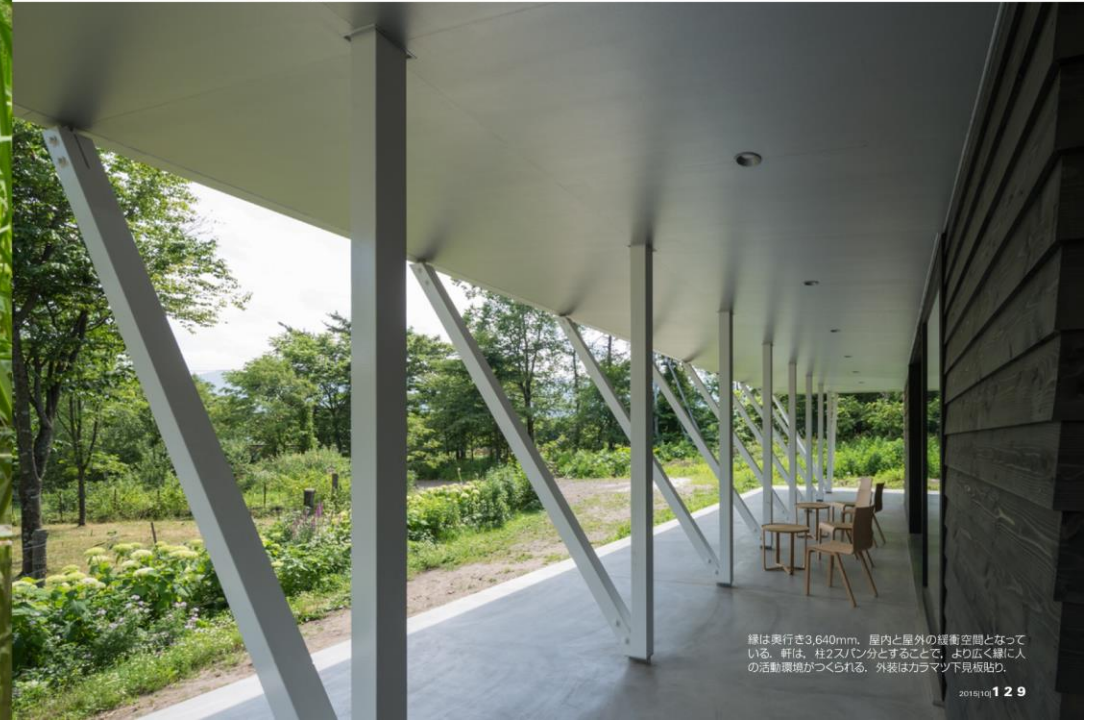
ホール、他に農機ツアアークエスタ、体験コーナー、事務室などを備える。軒によって室内に直射が入るのを防ぎつつ採光する。床下にはクールチューブを設置。
