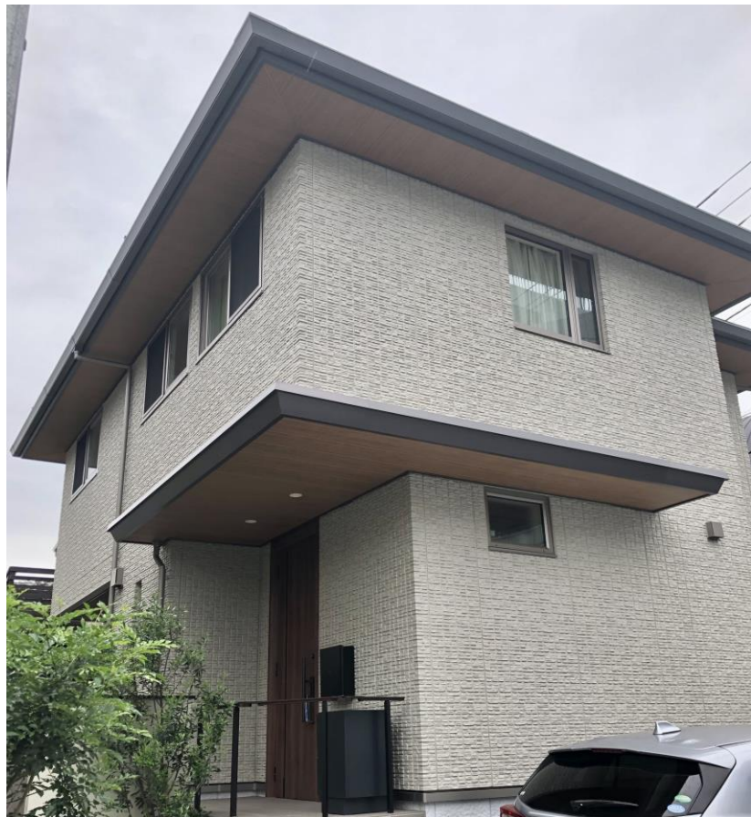
対象住宅 外観 撮影日：2023年6月22日
